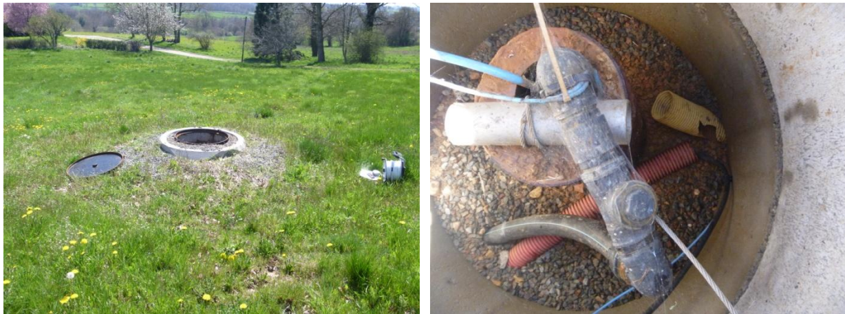
Figure 5 : Photographie de la tête de l'ouvrage
